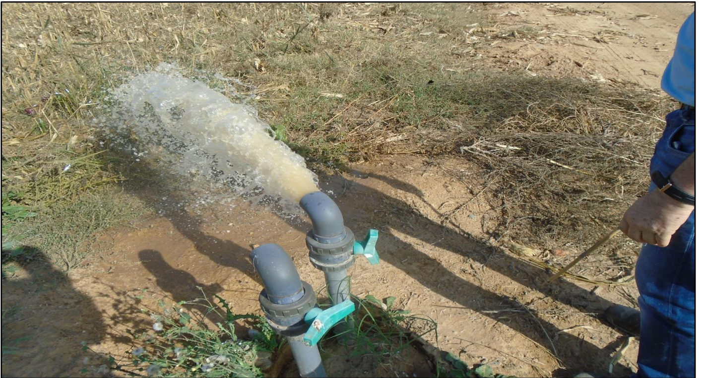
Figura 13. Vaciado de las tuberías del sistema RGS a fecha 03/11/2017.
